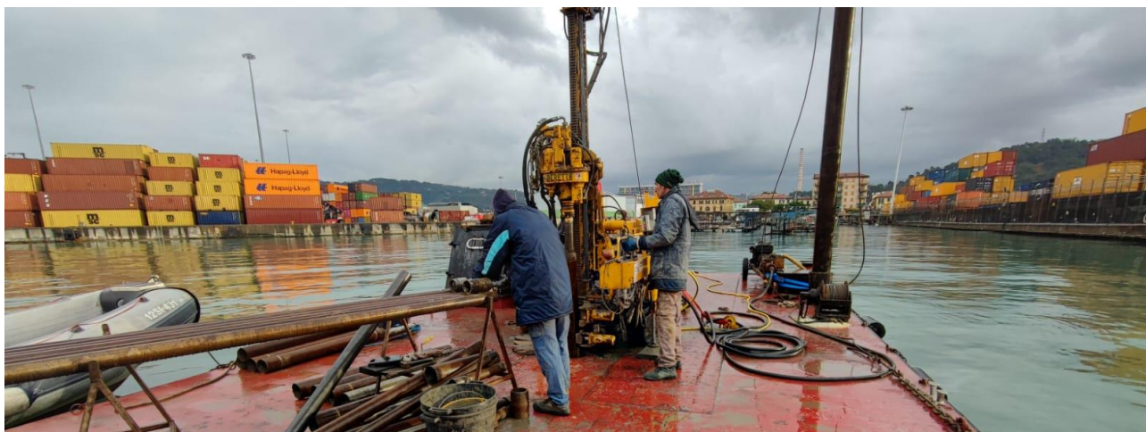
Figura 8 – Operazioni di campionamento mediante sonda a rotazione terrestre
